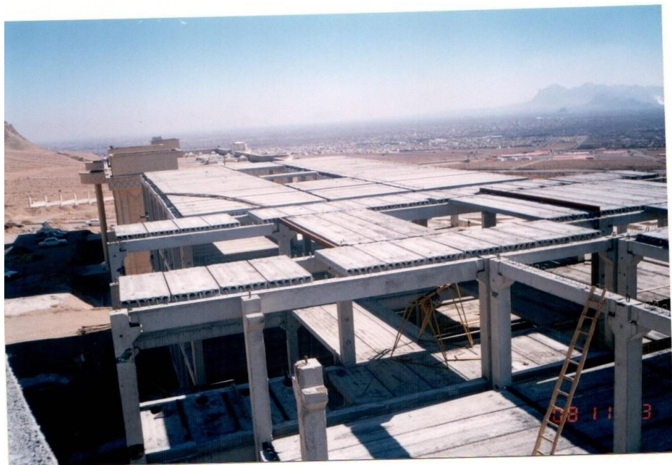
ساختمان پیش ساخته با سقف هالوکور
